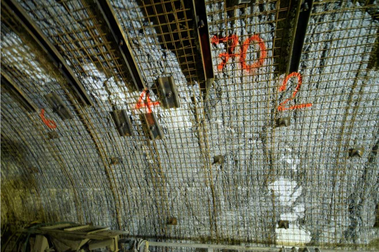
Blick auf den stark verfalteten, klüftarmen (trockenen), teilweise stark ausgebrochenen (Mitte oben) grauen Gneis mit den weißen Quarzmobilisaten hinter dem bereits mit Sicherungsankern (Quadrate mit Zapfen), Tübbings (U-Profile oben) und Baustahlmatten gesicherten Tunnelgewölbe.
